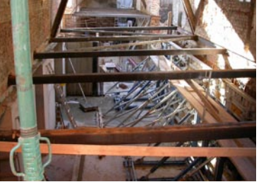
Deckenauswechslung Anbautrakt
