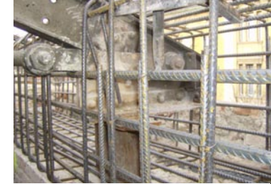
Einbindung in den Umfassungsrast
