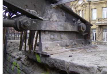
Fußpunkt des historischen Stahltragwerks im Mitteltrakt
